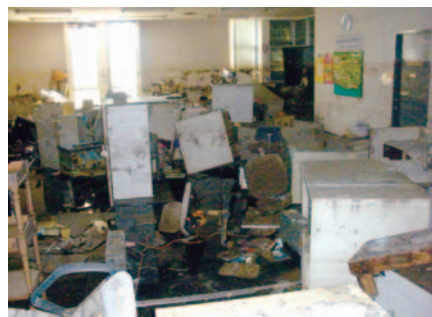
水が引いた後の事務所内
