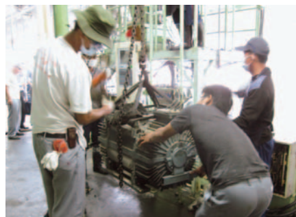
設備の分解・洗浄・組立を幾度も行いました
